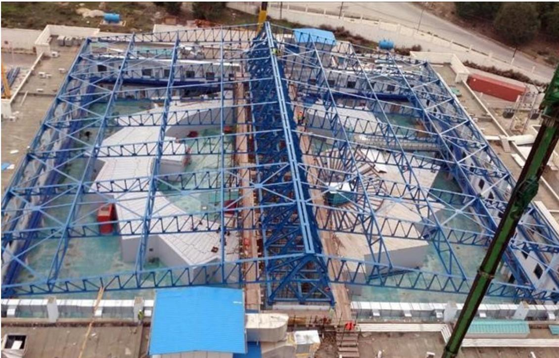
El sincrotrón Sesame, en Jordania, con el techo sin tapiar durante su fase de construcción, lo que permite apreciar la estructura circular del acelerador de partículas.
